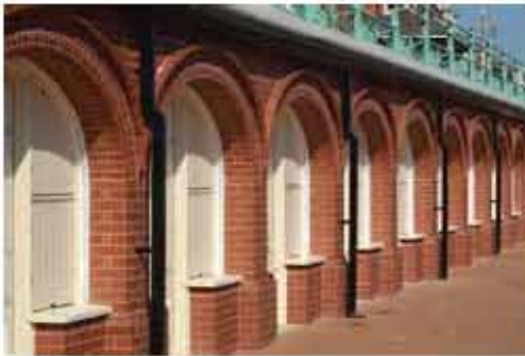
চিত্র ১১.২ : ইটের আর্চ
