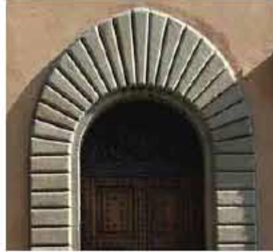
চিত্র- ১১.৩ (৬) ফ্লোরেন্টাইন আর্চ
