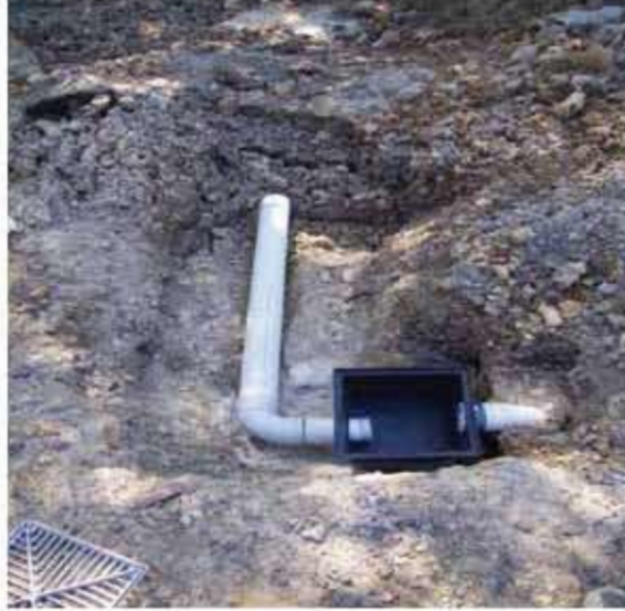
চিত্র ২৮.২ : ইন্সপেকশন পিট তৈরি প্রক্রিয়া
