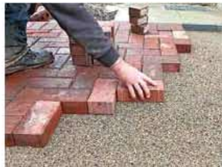
চিত্র-৯.৩ (২) ইটের সলিড এ ইট স্থাপন
