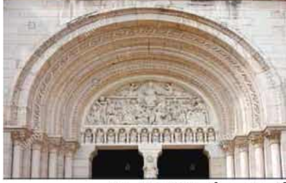
চিত্র- ১১.৩ (২) অর্ধবৃত্তাকার আর্চ
