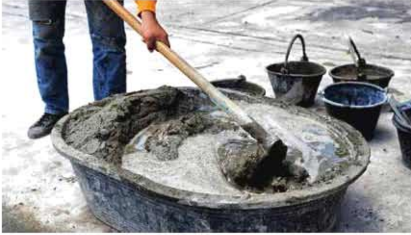
চিত্র-১৮.২ মসলা তৈরী করণ
