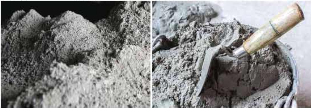
চিত্র-১৮.৪ (১) মসলা তৈরী করণ
