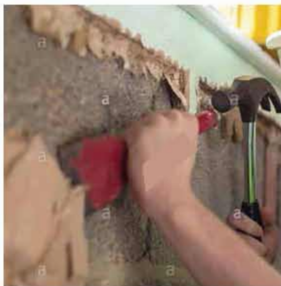
চিত্র: ১৯.৮(১) প্লাস্টার সারফেস প্রস্তুতি
