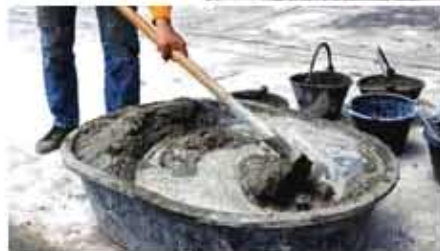
চিত্র-৬.২ মসলা প্রস্তুত
