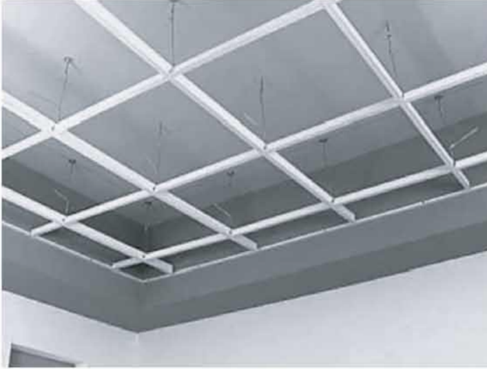
চিত্র ১৪.২: ফলস সিলিং-এ টাইলস যা পাইপ এবং তারের কাজকে সহজ করে।
